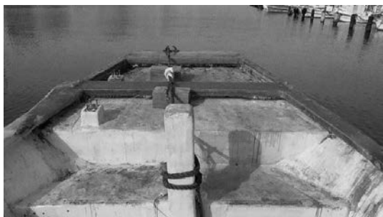
図 13 亀裂や穴をガラスクロスで補強
