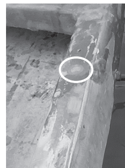
図 10 ボルトの凹を埋める
