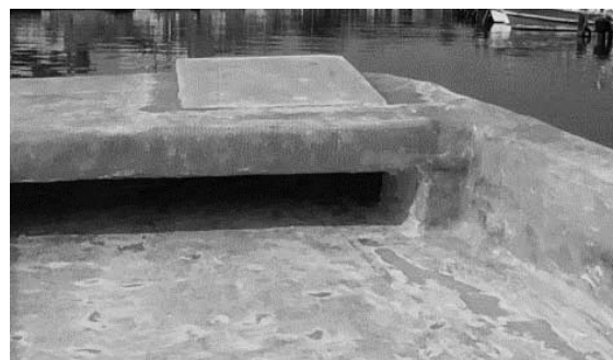
図 16 アンカー台に傾斜をつける木材
