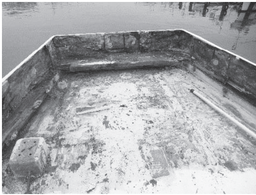
図4 腐敗した木材を除去
