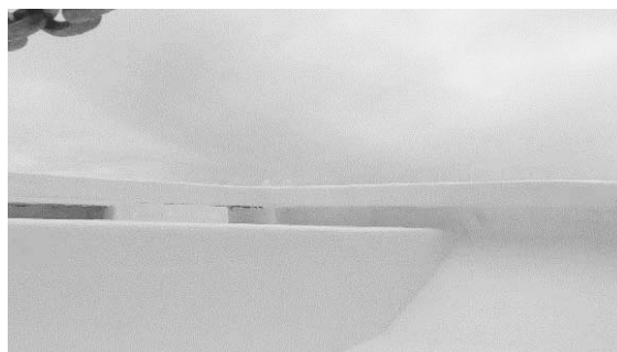
図 19 隙間や裏側にトップコート塗布
