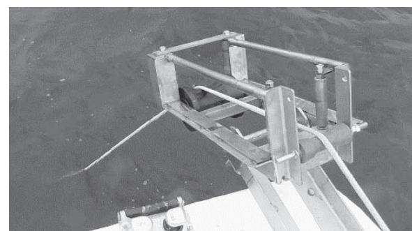
図 23 アンカーの動作確認
